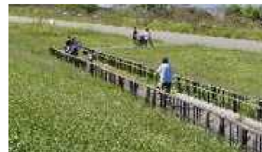
5-1 高水敷と天端を繋ぐ管理通路
