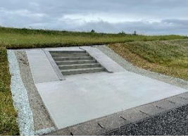
階段新設済（JR北側）
