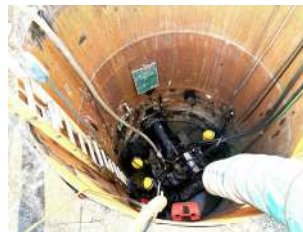
推進工施工状況
