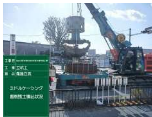
立坑掘削状況
