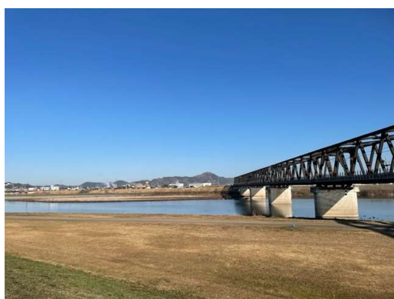
JR 南側スロープ途中からみた水面
