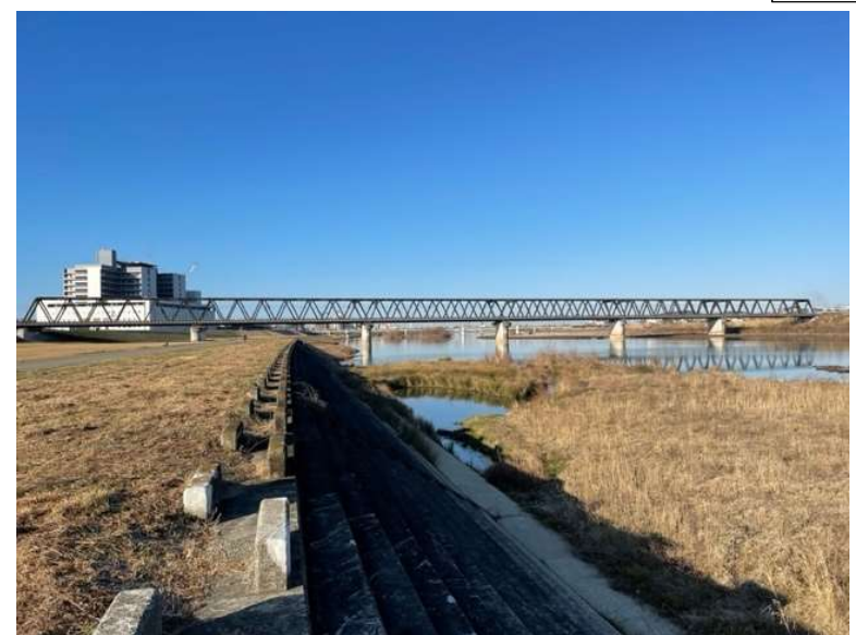
加古川堰堤付近下流側の護岸
