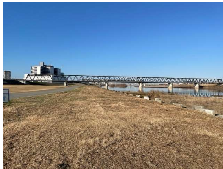
加古川堰堤付近から下流側
