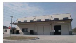
加古川市 資源化センター
