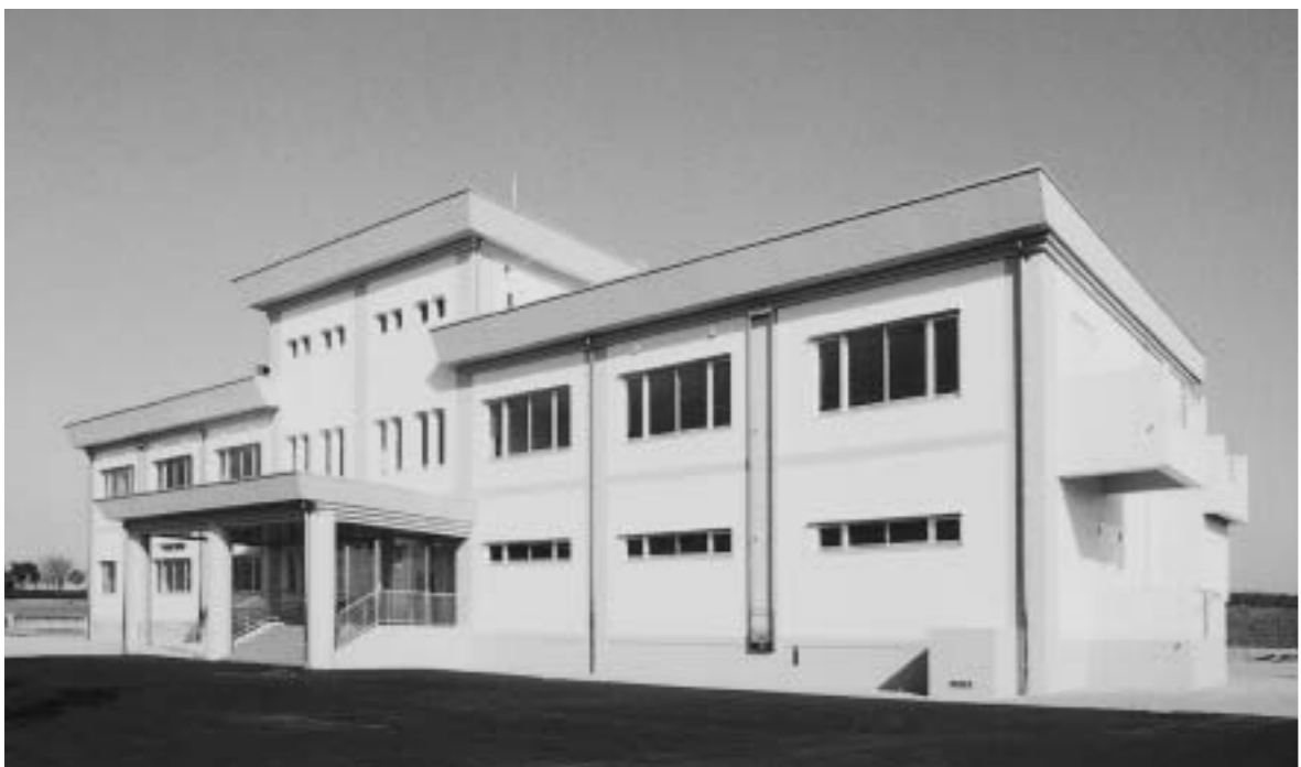
中西条浄水場の新管理棟
