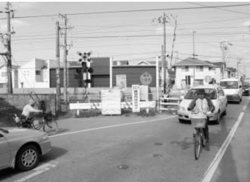
拡幅が要望されている西谷踏切。
