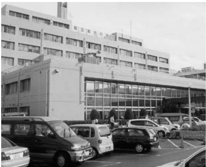
移転が予定されている県立加古川病院。
