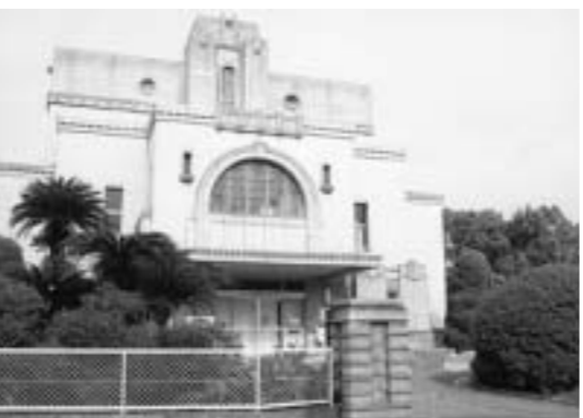
金剛寺浦公園に隣接する加古川市立図書館。
