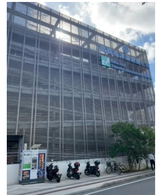
那覇市津波避難ビル外観
