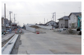
▲都市計画事業で施工中の市道中津水足線
