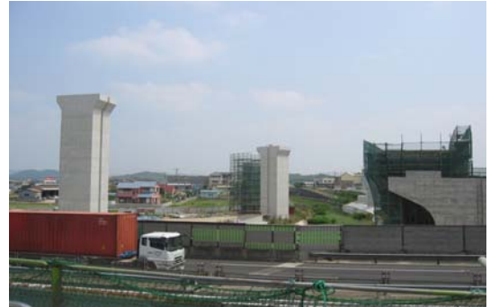
▲橋脚の建設が進む現場(手前は加古川バイパス)
