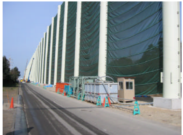
【建設が進む防じんネット】
