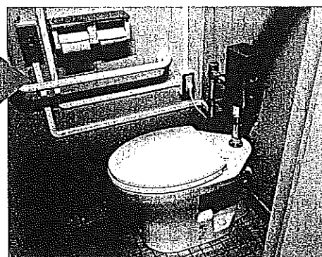
改修後の新館1階女子トイレ
