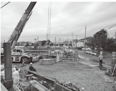
▲工事中の大野西条線
