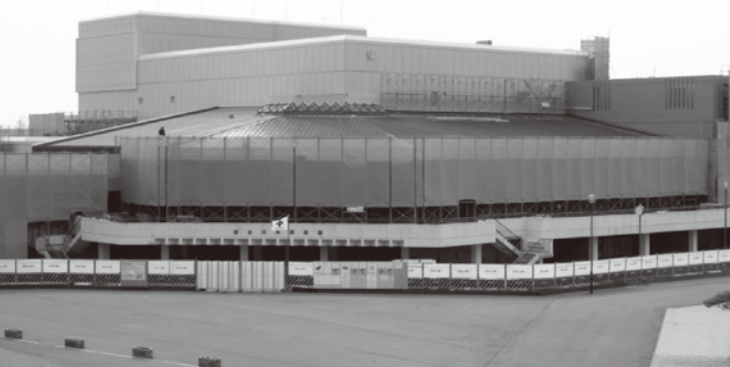
▲改修工事の進む市民会館
