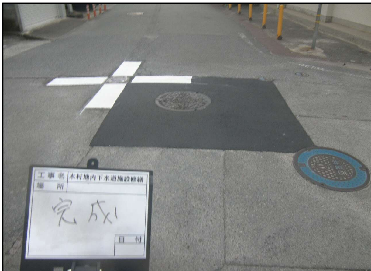
緊急修繕 完了後 (受枠から新たな蓋に交換)
