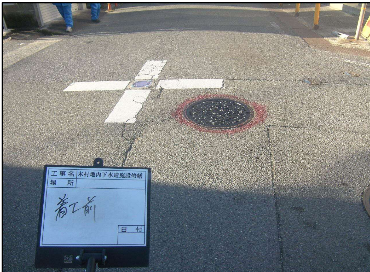
緊急修繕 着工前 (蓋のみ直ちに交換している)
