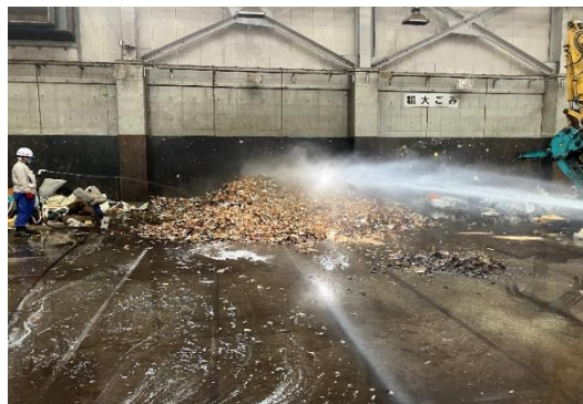
不燃・粗大処理施設プラットホームでの放水作業
