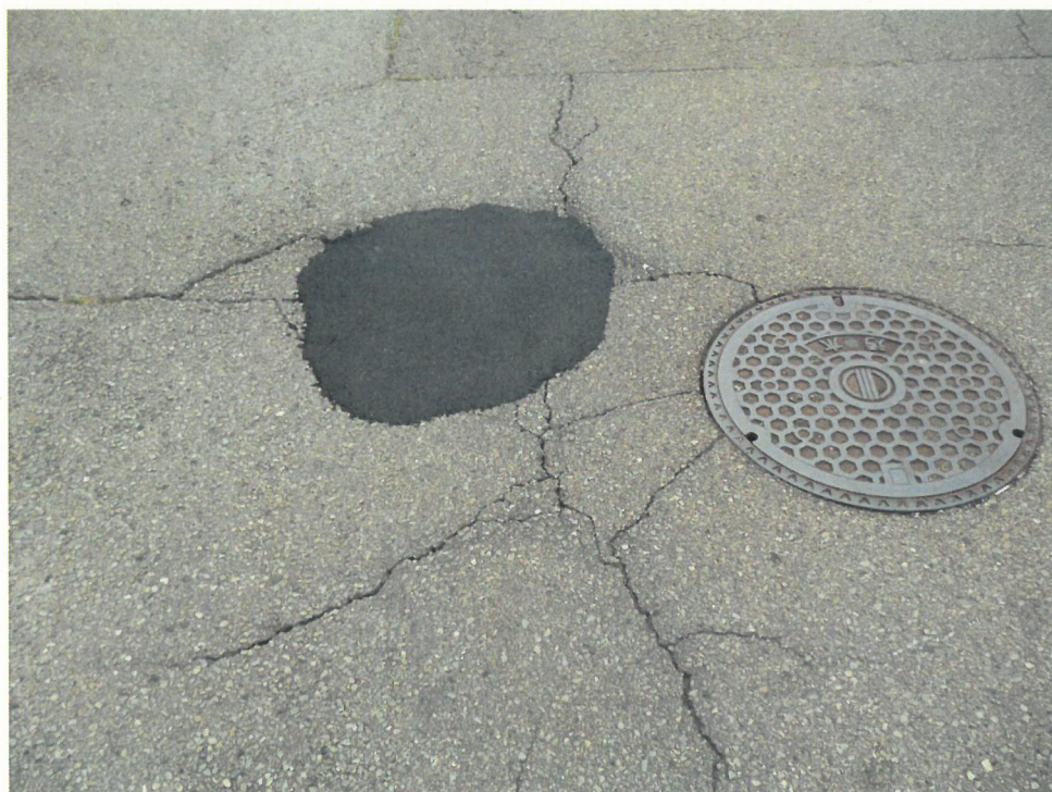
応急措置後 の状況 (近景)
