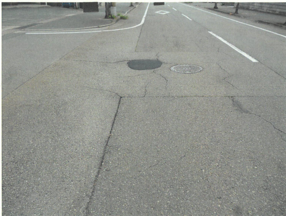
応急措置後 の状況 (遠景)
