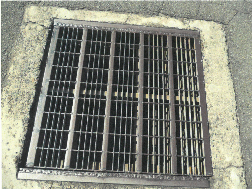
雨水枡の状況
