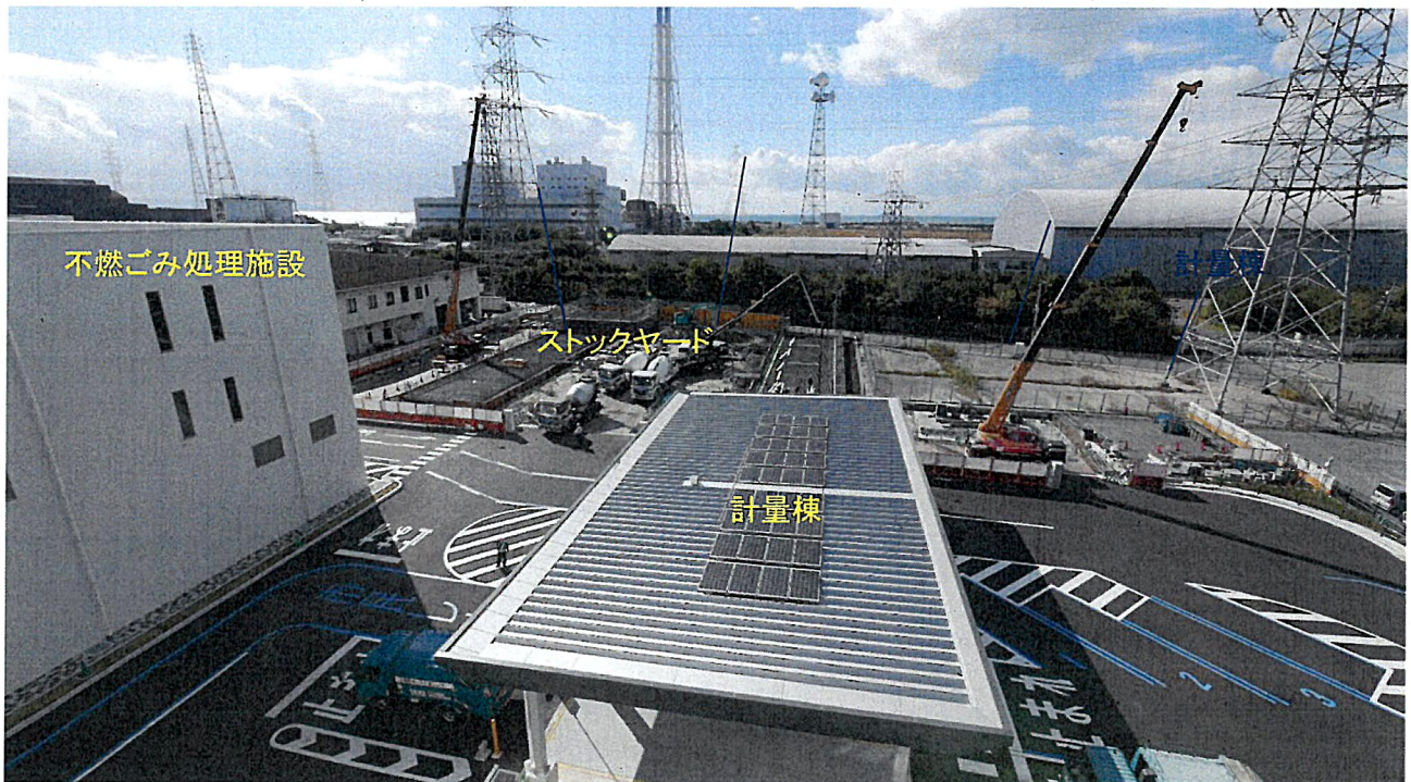
管理棟5階からストックヤード建設工事(南側)を撮影
