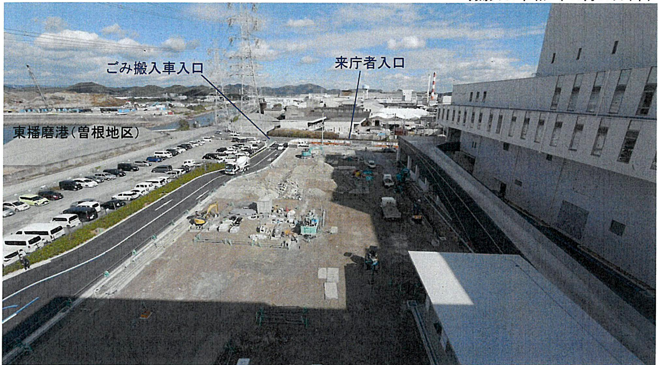
管理棟5階から敷地入口方面(北側)を撮影
