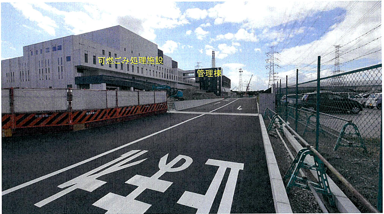
ごみ搬入車入口から撮影
