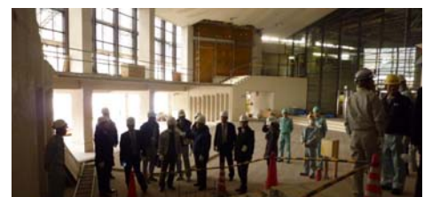
▲改修工事中の市民会館(1階エントランス部分)
