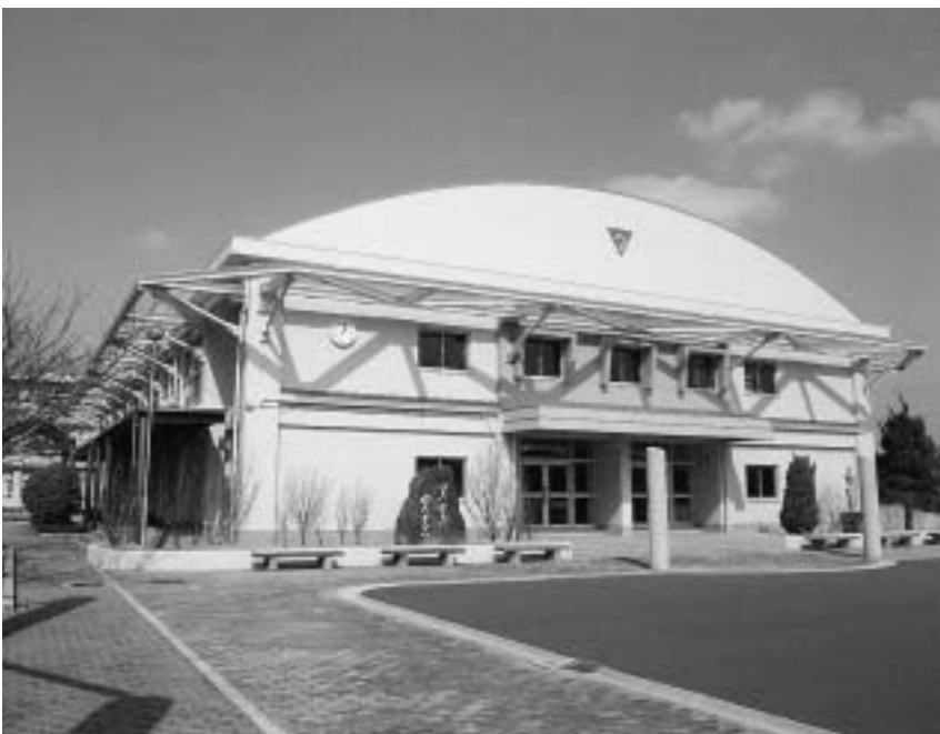
耐震化工事が完了した西神吉小学校の体育館
