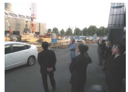
（処理施設の建設現場で担当者から説明を受ける）
