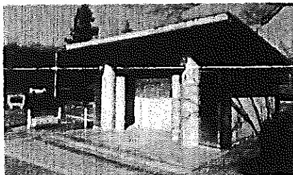
第5駐車場横のトイレ
