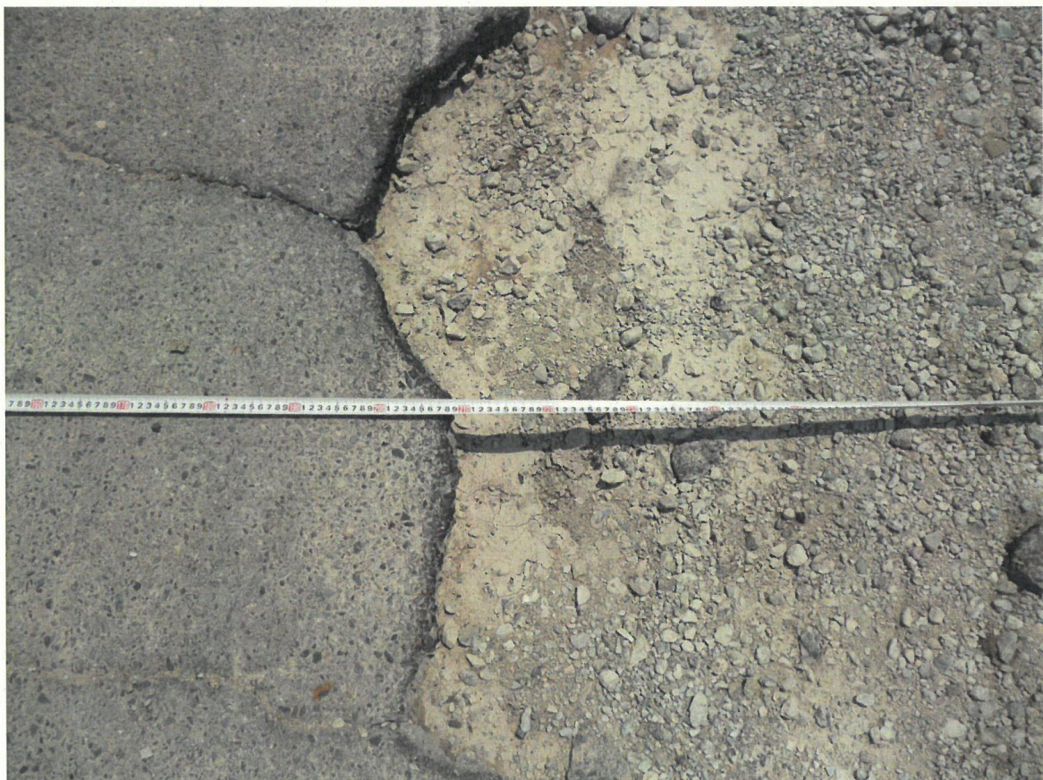
池田開拓地16号線 路肩に舗装欠損有
