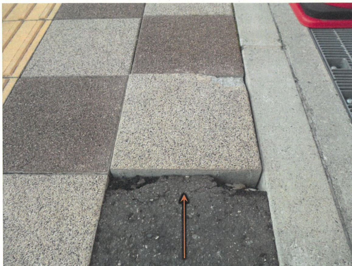
アスファルト補修箇所の欠損有
