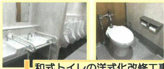
和式トイレの洋式化改修工事
