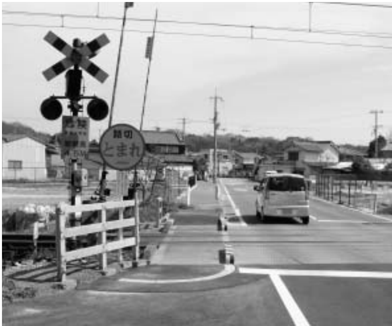
歩道が整備された踏切（日岡駅北）
