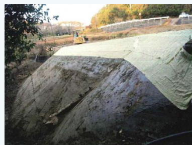
地藏堂下池の改修事業(淡路市)
