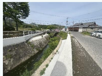
今出川護岸改修事業(淡路市)
