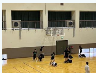
空調設備整備事業(豊岡市)
