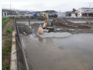
ため池の改修事業(南あわじ市)
