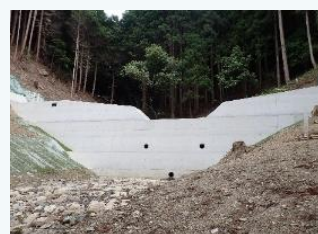
治山ダムの整備(兵庫県)
