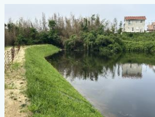
ため池堤体改修工事(淡路市)
