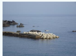
町営漁港防波堤改良事業 (新温泉町)
