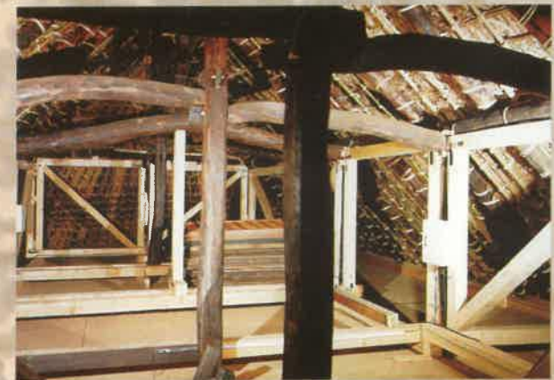
耐震補強した屋根裏構造
