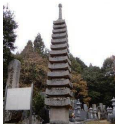
報恩寺十三重塔
