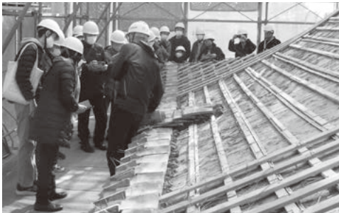
鶴林寺鐘樓修理工事現場見学会のようす
