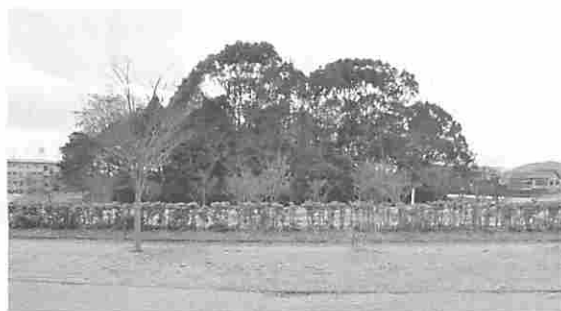
整備工事途中の人塚古墳
