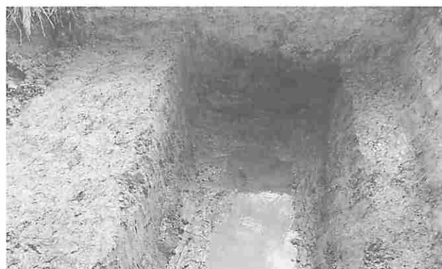
砂部遺跡（鉄塔建設）
