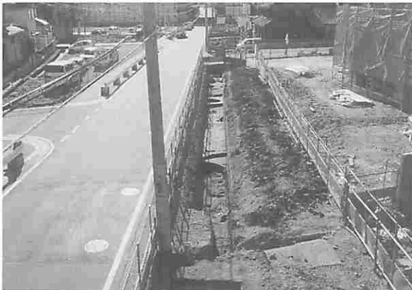
溝之口遺跡（市道拡幅工事に伴う調査）
