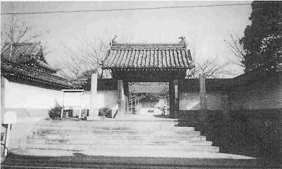
山陽道（西国街道）より 山門・境内地を望む（南から）
