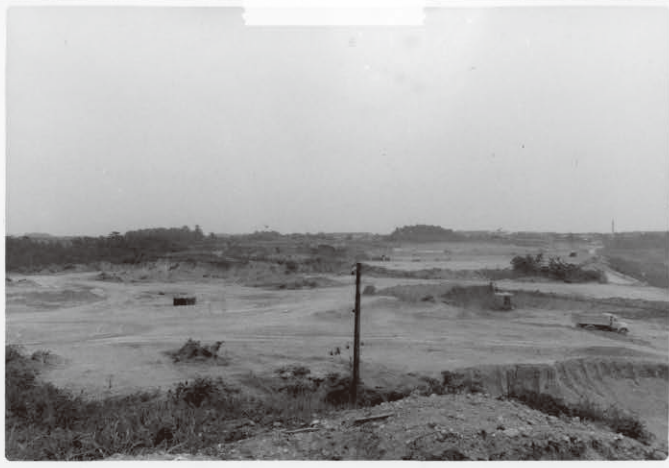
造成工事の様子
