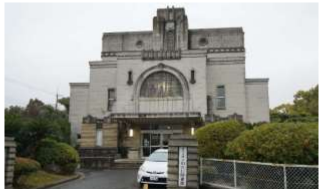
加古川図書館（旧加古川町公会堂）
