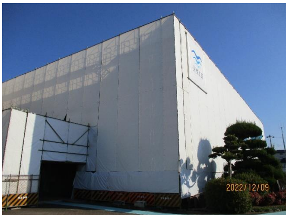
体育館の外壁改修
