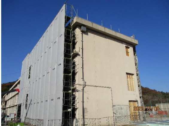
特別教室棟（東側）の外壁改修
