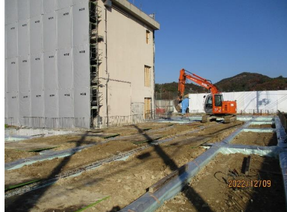
教室棟増築部の基礎工事
