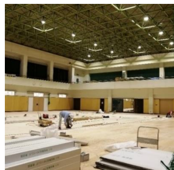
体育館の床改修工事
