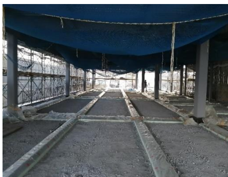
増築する教室棟の内部
