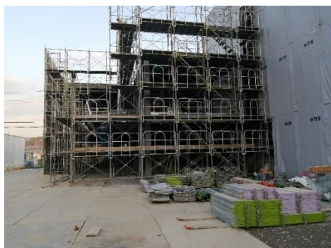
増築する教室棟の鉄骨工事
