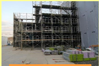
両荘みらい学園整備工事
