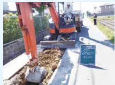
汚水管渠の工事
