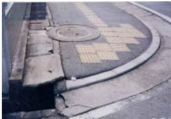
写真 蓋がない、または破損している側溝
