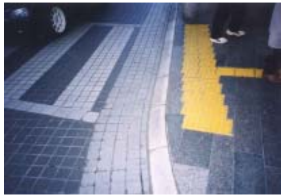
写真 歩車道境界段差 2cm 以上の交差点
