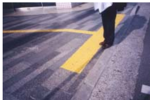
写真 すりへり、設置方法などの問題がある誘導用ブロック
