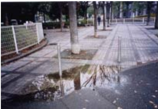
写真 横断歩道部における排水、歩道舗装面の不陸・不等沈下など
