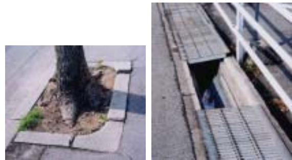
写真 横断歩道部における排水、歩道舗装面の不陸・不等沈下など
