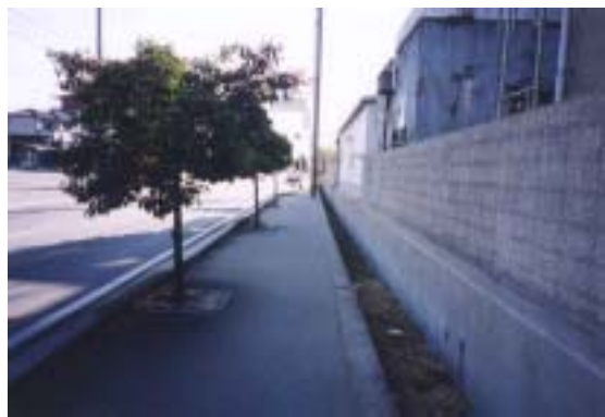
写真 蓋がない、または破損している側溝
