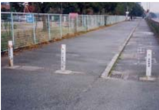
写真 表示が消えている歩行者自転車道
