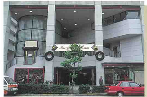
低層部の店舗にアクセントカラーを配し、賑わいを演出しています。
