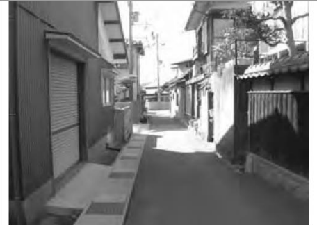
側溝にフタ掛けした道路 塀や建物の趣を残しつつ、道路は美 しくなっています
