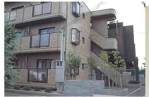
建物と同材料とするとともに、屋外階段が目立たないよう植栽を施しています。
