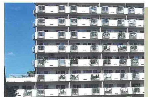
エアコン室外機等が外部から見えにくい構造にしています。
