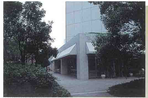
庇を建物と同色でスッキリと仕上げています。
