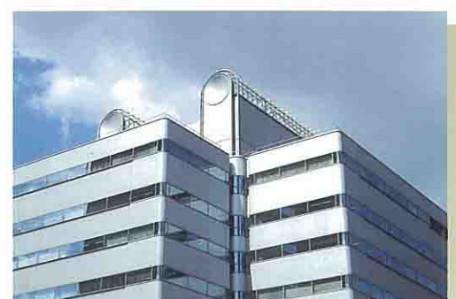
屋上設備を積極的にデザイン要素としています。
