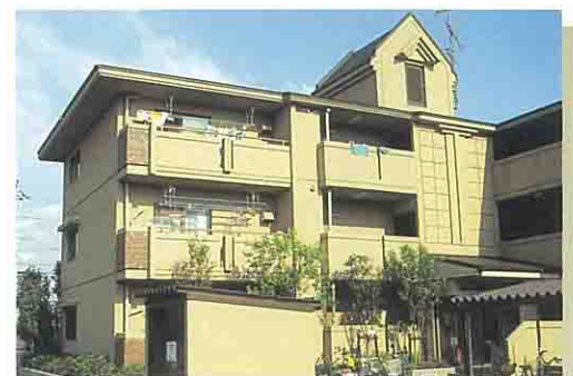
屋上設備は、建築デザインの一部となるよう工夫しています。
