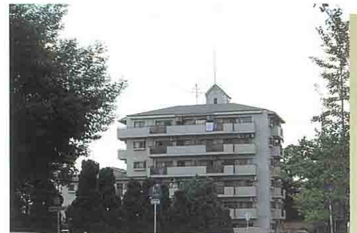
屋根に勾配をもたせるとともに、周辺の樹木に調和する色彩を用いています。
